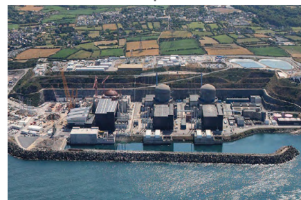
La Centrale nucléaire de Flamanville utilise l'eau de mer comme liquide de refroidissement
