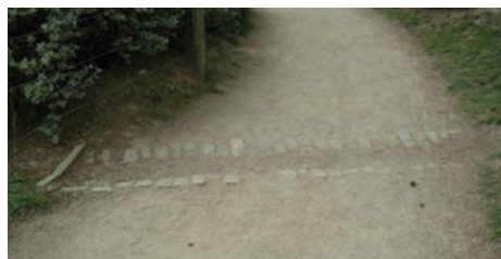
Mise en place de caniveaux et drains sur le sentier côtier
