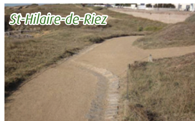
Mise en place d'un caniveau empierré sur le sentier côtier
