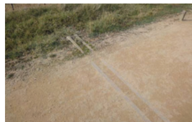
Drain en bois souvent mal calé (pente insuffisante)
