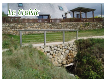
Passage du sentier côtier en passerelle, avec mur de soutènement
