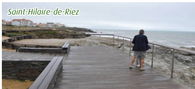
Aménagements de belvédères en platelage bois
